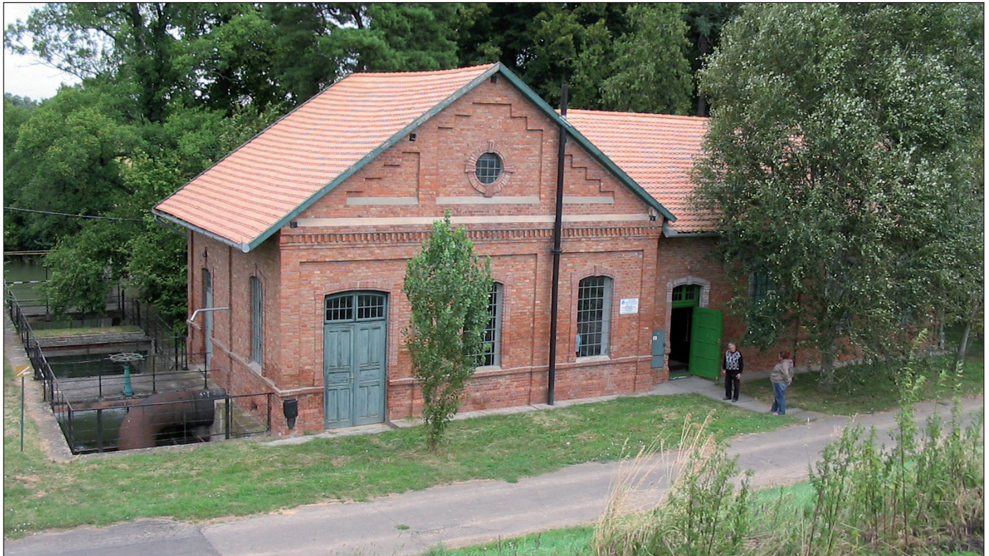
Peres I. szivattyútelep
