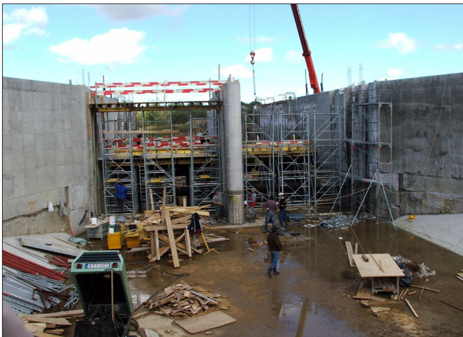
Kenyeri kisvízerőmű építési munkái
