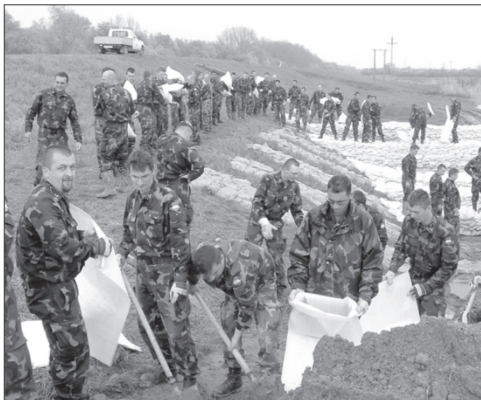
Bordás megtámasztás Gyomaendrőd belterületén
