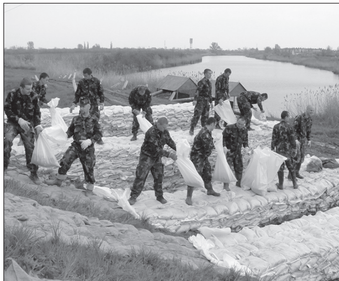
Bordás megtámasztás a Fűzfás-zugi holtágnál
