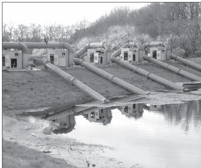
KÖRÖS 500 szivattyú-provizórium a Hortobágy-Berettyón
