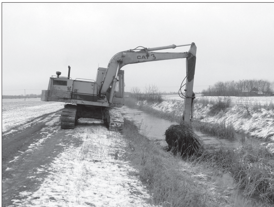
Vízfolyástgátló akadály eltávolítása az Újszörhalmi csatornán
