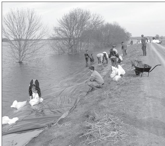
Hullámverés elleni védekezés a Hortobágy-Berettyón
