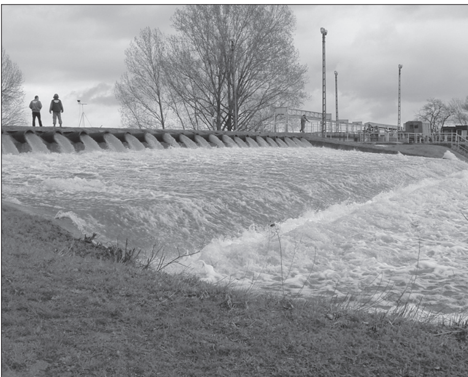
Hortobágy-Berettyó Árvízkapu szivattyúprovizóriumok
