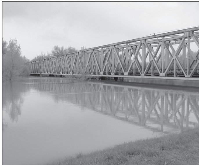
Gyomaendrődi vasúti híd
