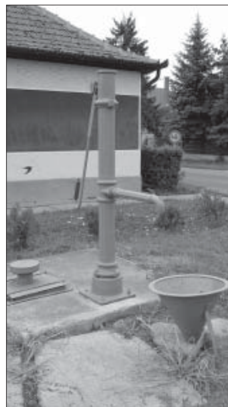
A használaton kívüli B-10 kataszteri számú kút a Kispince és Nyíri utca sarkán. 1908-ban létesült, 130,0 m. mélységű. Araczk György kútúró munkája.
